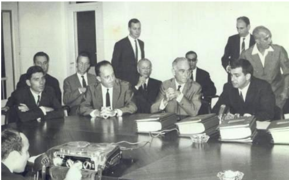
Signature du contrat de construction de l'usine d'ammoniac d'Arzew À la table, à gauche, la délégation française, à droite le PDG de Sonatrach Sid Ahmed Ghozali. Debout derrière à gauche, Fernand Gallinari
