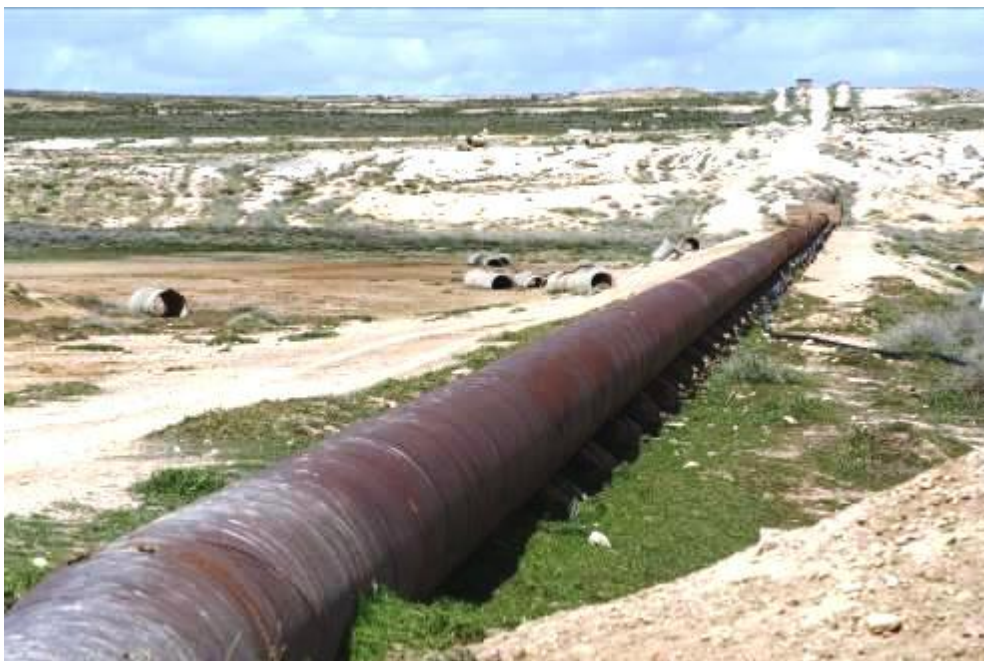
photo 1A conduite d'eau en fonte de 600 mm de l'ancien réseau d'irrigation
